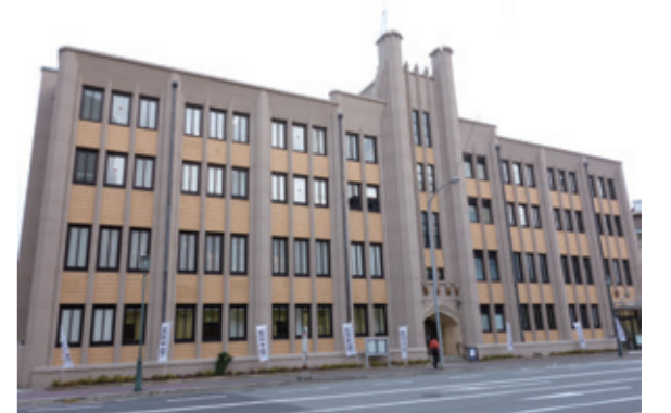
図2 旧神戸市立生糸検査所
